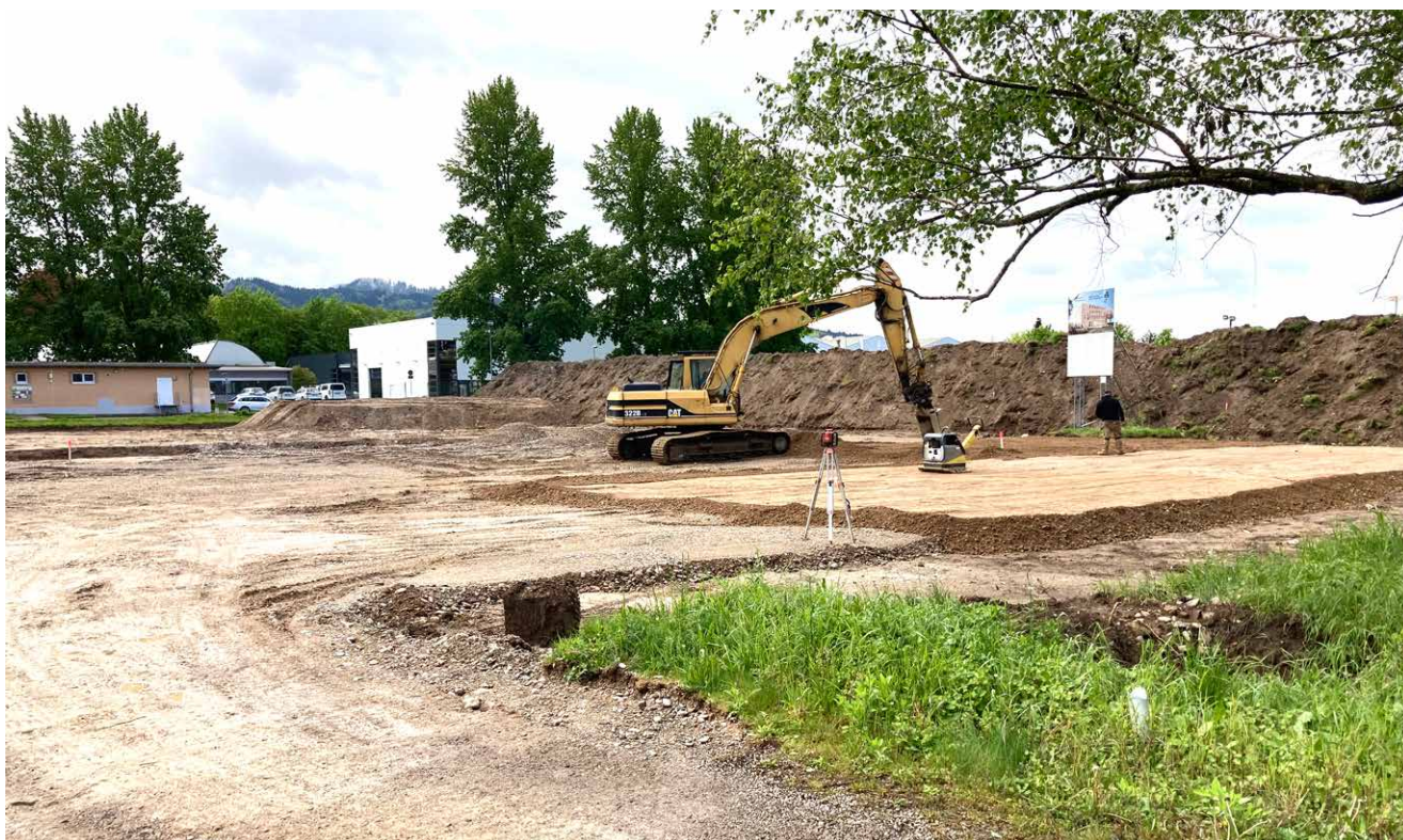
Der BDB baut aktuell analog und digital. Während für den Akademie-Neubau die Fundamente gelegt werden, läuft bei der BDB-Online-Akademie der Betrieb an – bei stetig wachsendem Angebot.
